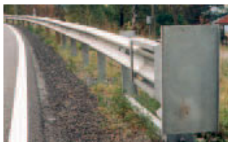
Skarpkantet ettergivende rekkverksavslutning, som kan gi stor skade på en motorsyklist.
