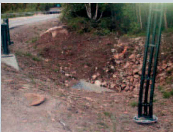
Rv 23 Oslofjordforbindelsen. Vegutstyr er plassert der hvor sannsynligheten for utforkjøring med MC er størst, i utgangen av undkjøringene.
