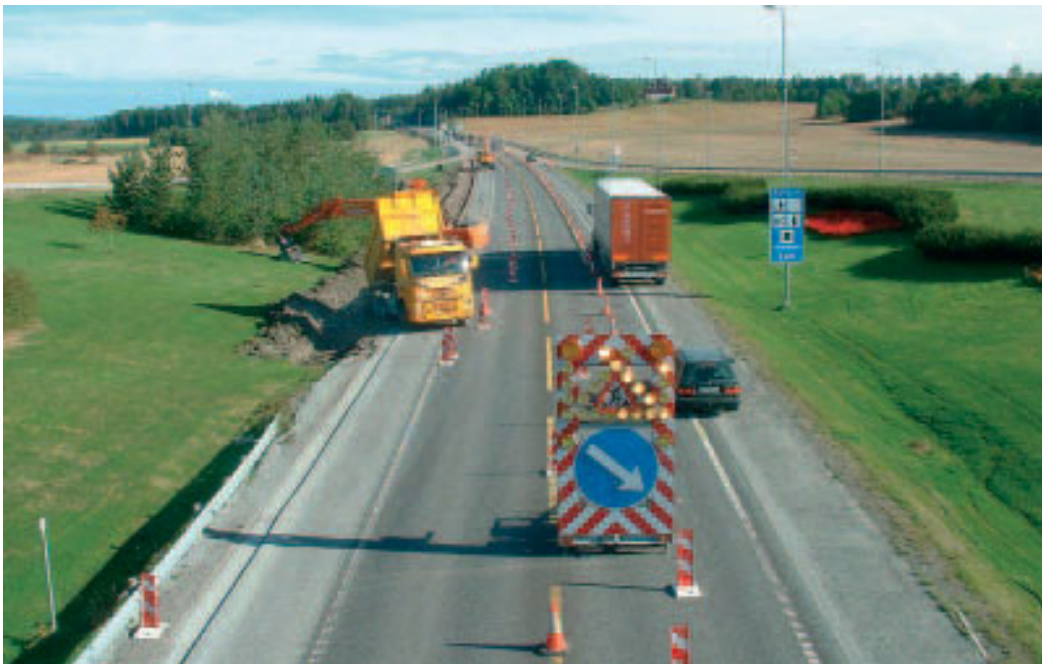
Strekning der det foregår vegarbeid
