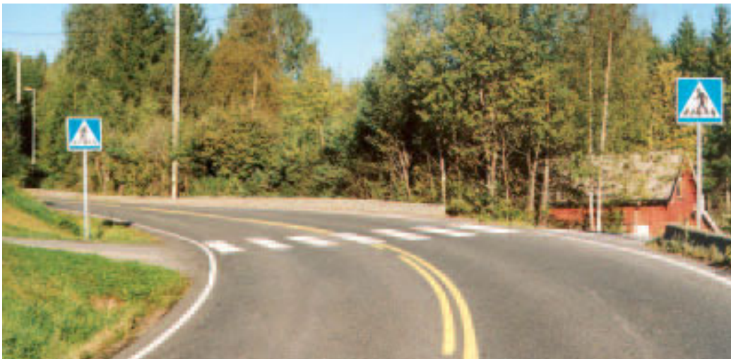
Gangfelt i sving bør unngås fordi motorsyklister kan skli på den glatte oppmerkingen og fordi sikten til kryssende fotgjengere kan bli dårlig.
