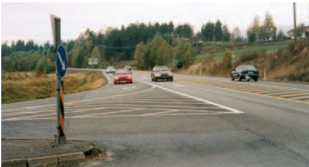
Rv 35 Vikersund sør. En stor bil i høyresvingefeltet vil skjule en motorsyklist som kommer i gjennomgående felt.
