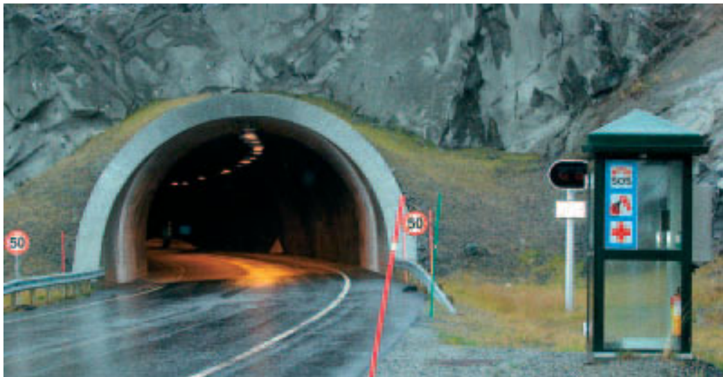
Tunnelåpning, Honningsvågtunnel på Magerøya
